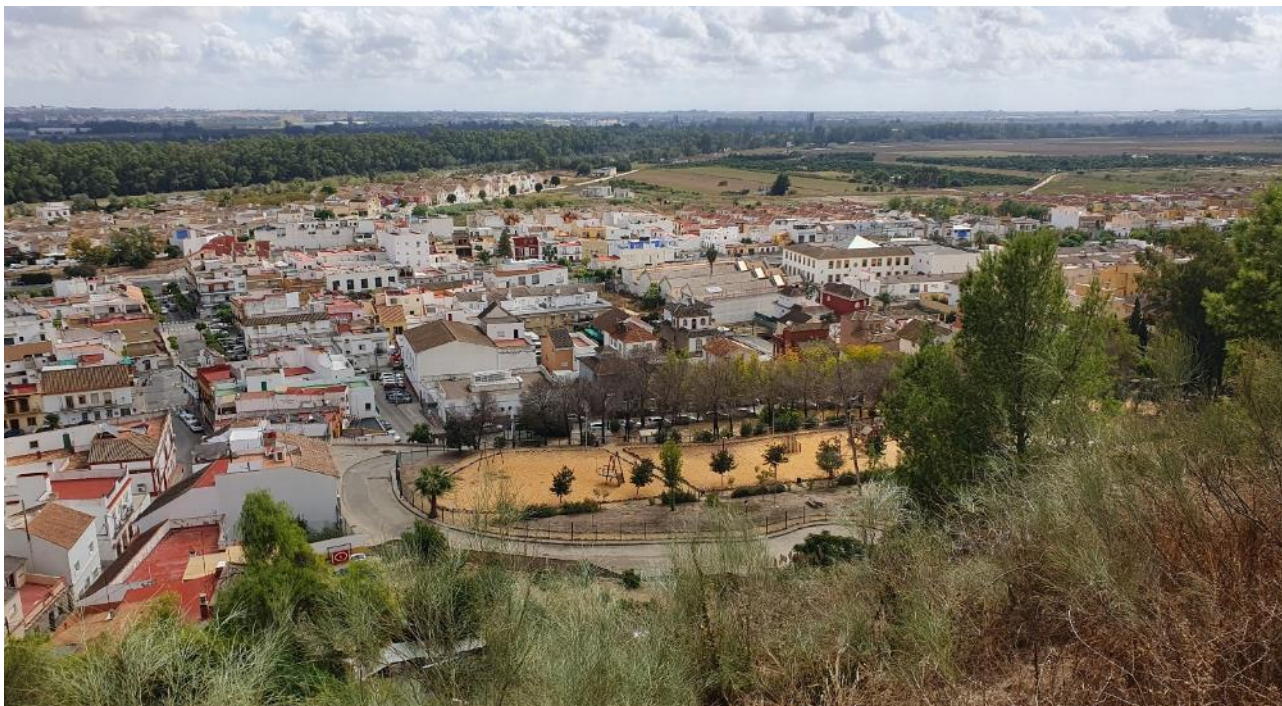
Vistas desde la Cornisa este del Aljarafe donde se observan los dos elementos paisajísticos lineales con claridad.
